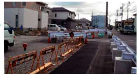
建物移転、道路工事等が進む宝町地区
